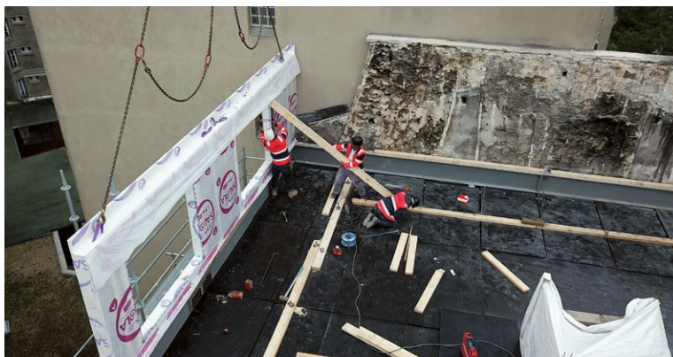
La pose des 1 ères façades "bois" © Alexis Joly
