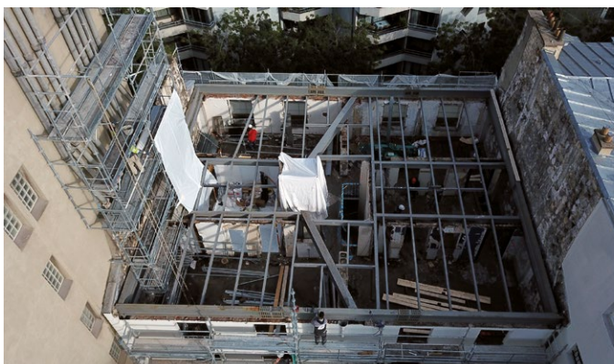
Le montage de la structure métallique du plancher de reprise (PH +5) © Alexis Joly
