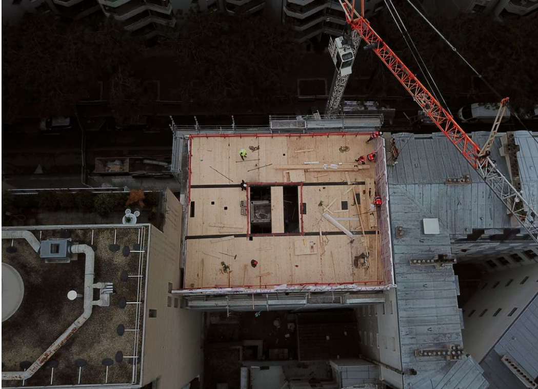
Une grue "treillis" pour la pose des structures supérieures © Alexis Joly
