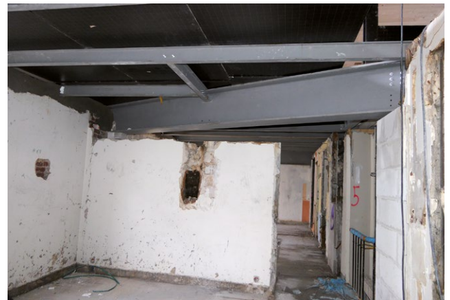
La lourde structure métallique du plancher de reprise (PH +5)
