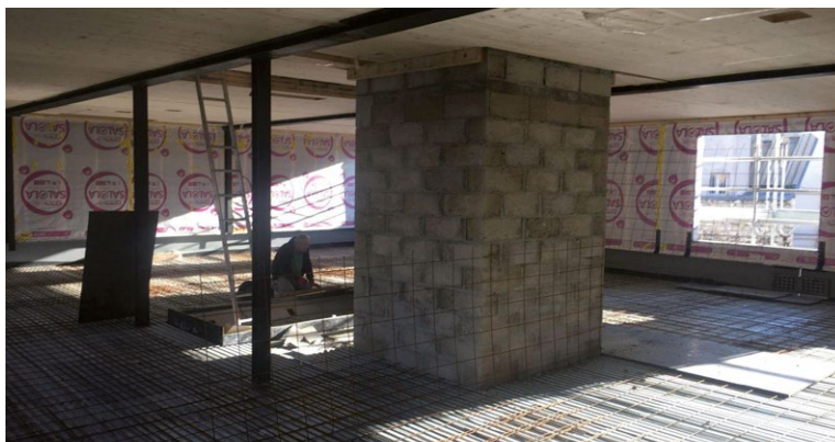
La mise en œuvre du plancher de reprise du PH+5 © Olivier Terrones
